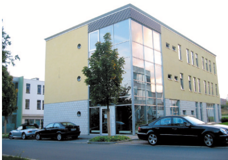
S & P Consult - Gebäude, Konrad-Zuse-Straße 6
