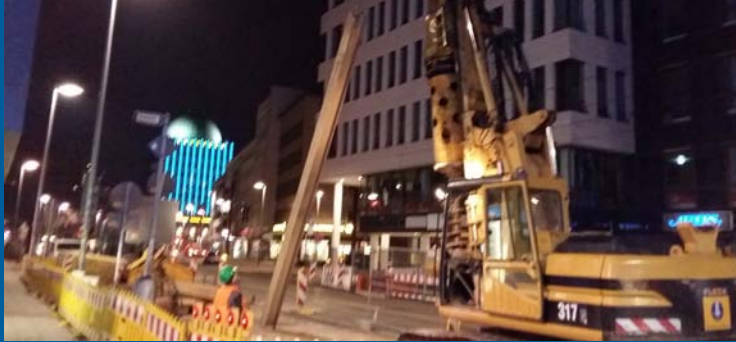
Nächtliches Einbringen der Bohrträger in Hannover
