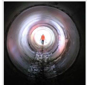
Blick durch die verlegten GFK-Rohre in Richtung Baugrube
