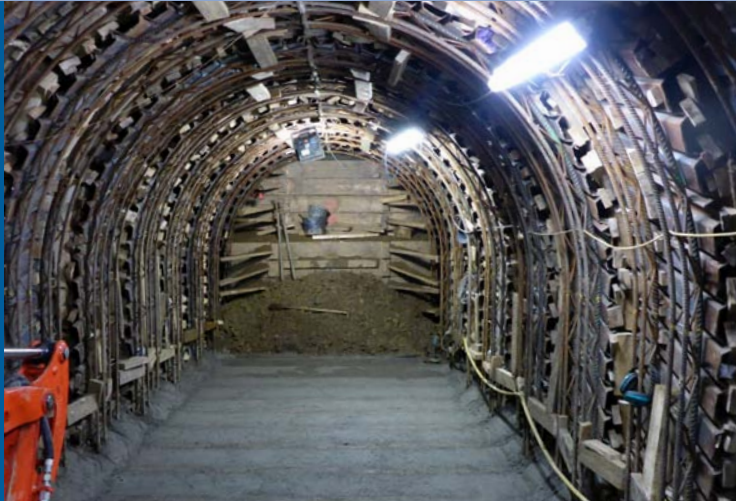
Blick auf die gesicherte Ortsbrust des verbauten Stollens
